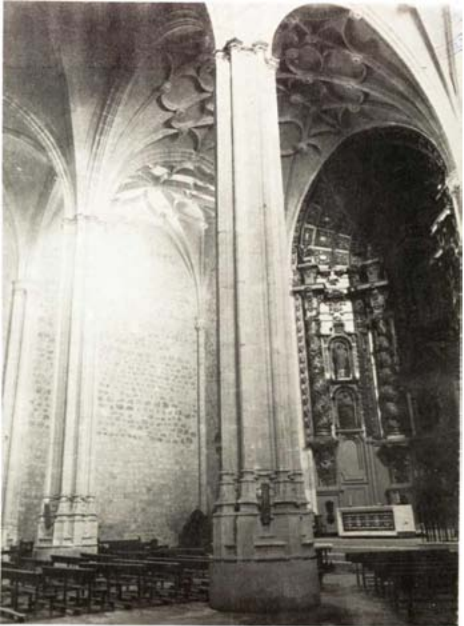
FOT. 4 — VILLAR ROBLEDO. Parroquia de San Blas. Interior. Primer tramo gótico de la obra. Nueva.
