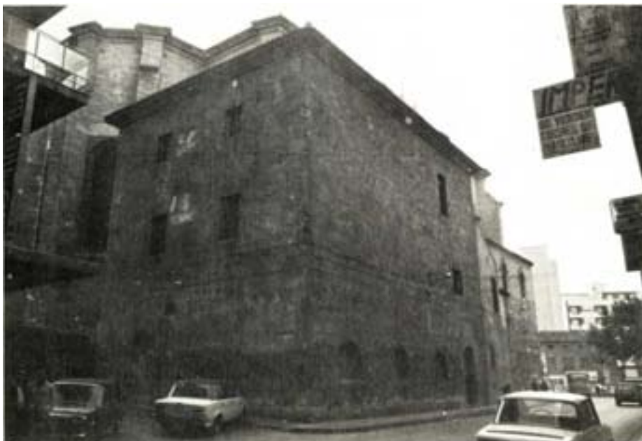
FOT.41 —ALBACETE. San Juan Bautista. Sacristía, exterior. Obra de Juan Cubero.
