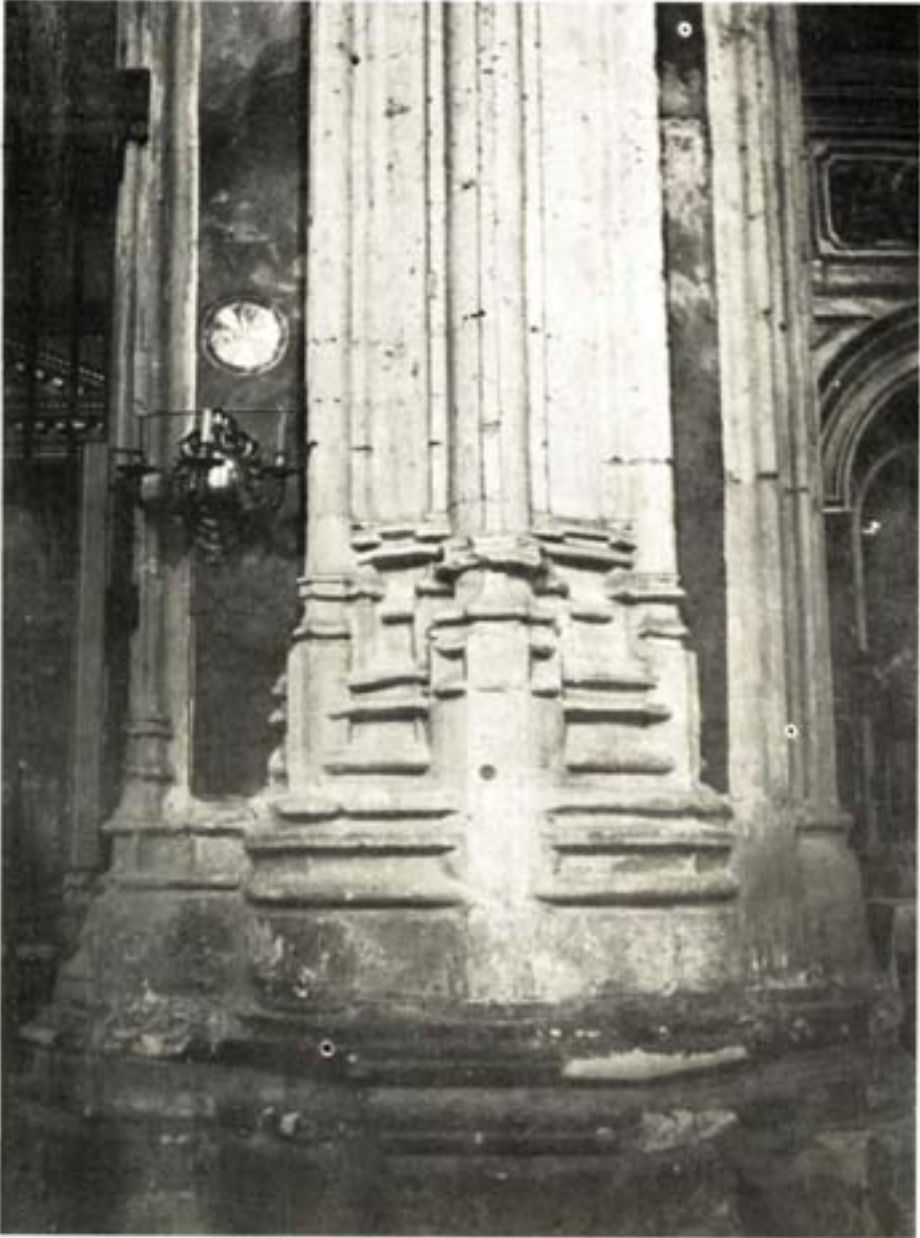
FOT.20—ALBACETE. San Juan Bautista. Basa de un pilar adosado gótico, compárese con las de Villarrobledo (fot. 4).
