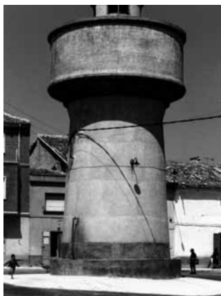
Depósito de agua en Mahora
