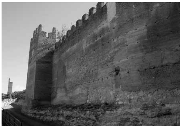
Muralla de tapial almohade en Jorquera
