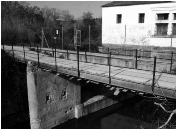
Bolinches, la central y el cauce de desvío
