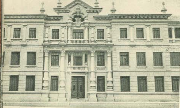
FACHADA DEL COLEGIO S. A. D. E. L.
