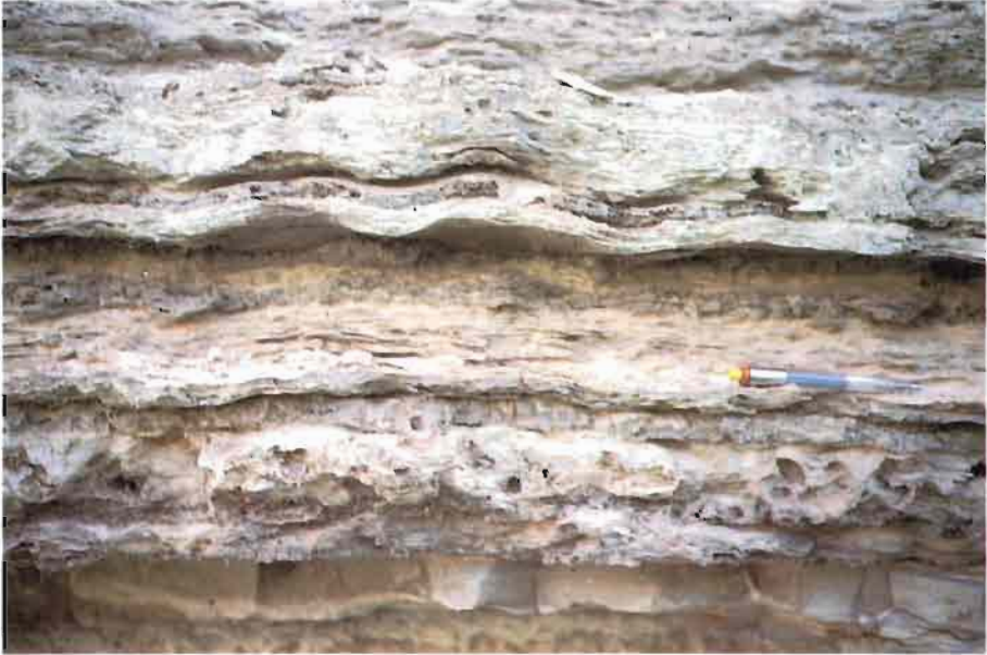
Fotografía CM4.3. Niveles de yeso laminado a techo del ciclo inferior del tramo 3 de la sección Río Mundo (CM4).
