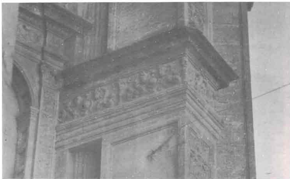
Fig. 5.- Santa María de Chinchilla. Detalle del exterior del ábside.
