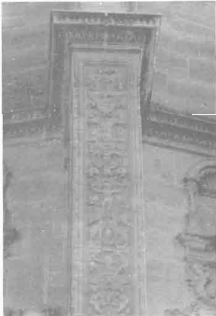
Fig. 4.- Santa María de Chinchilla. Detalle de un contrafuerte.
