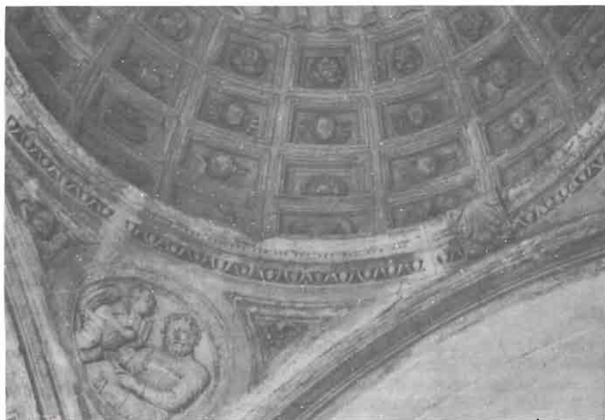
Fig. 13.- Santa María de Chinchilla. Detalle de la cúpula.
