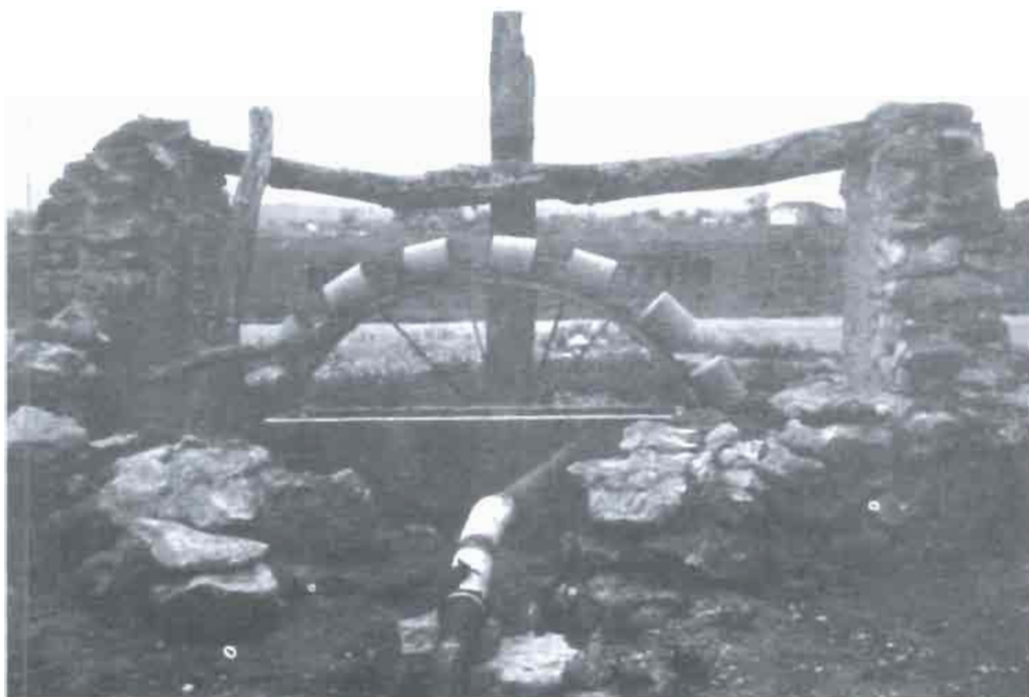
Arte para riego por aguas elevadas de los niveles piezométricos más someros, hoy desaparecido. Foto López Bermúdez
