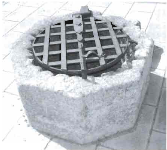
Uno de los brocales del aljibe cubierto de Chinchilla, con sus bordes mordidos del roce de las sogas.
