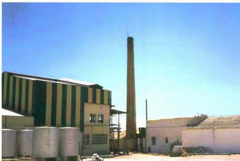
Fot. 64.- Hellín. Chimenea industrial. Resinas y Colofonias (La Resinera)
