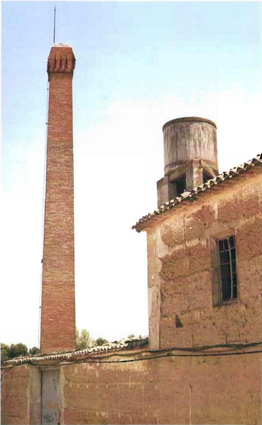
Fot. 49.- Villarrobledo. Chimenea industrial
