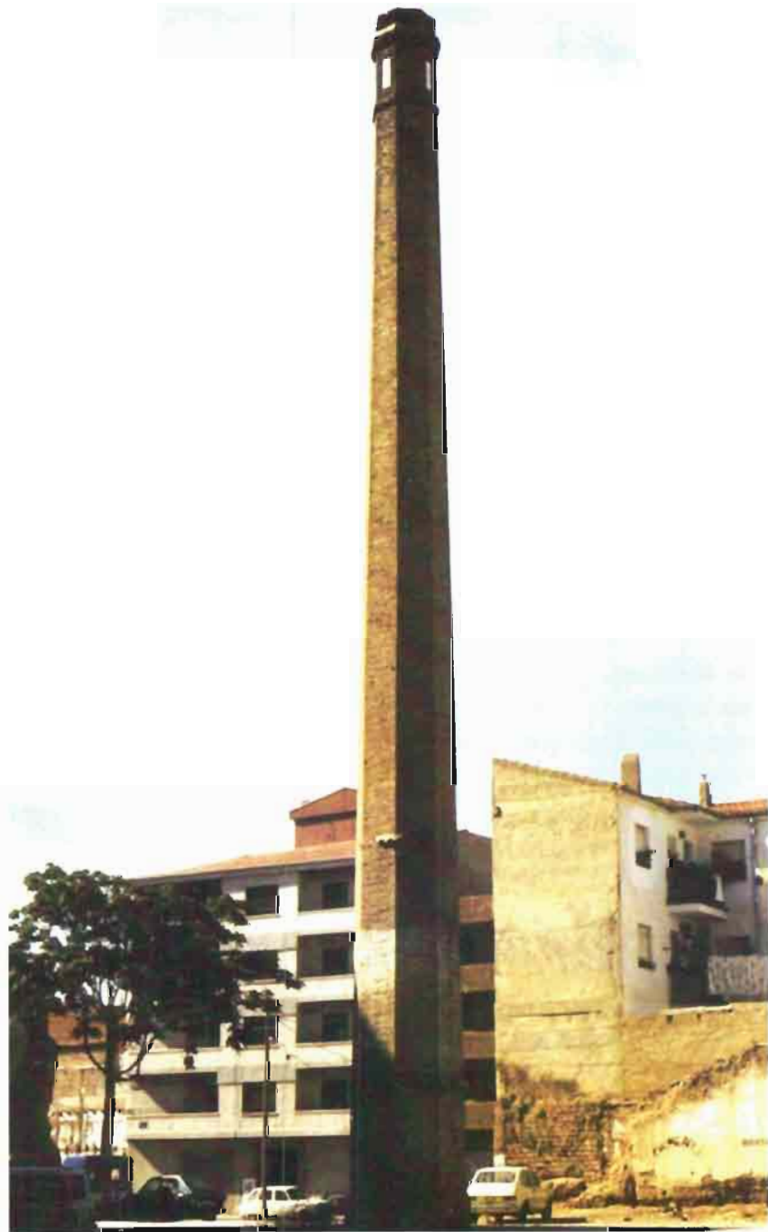
Fot. 14.- Albacete. Chimenea industrial
