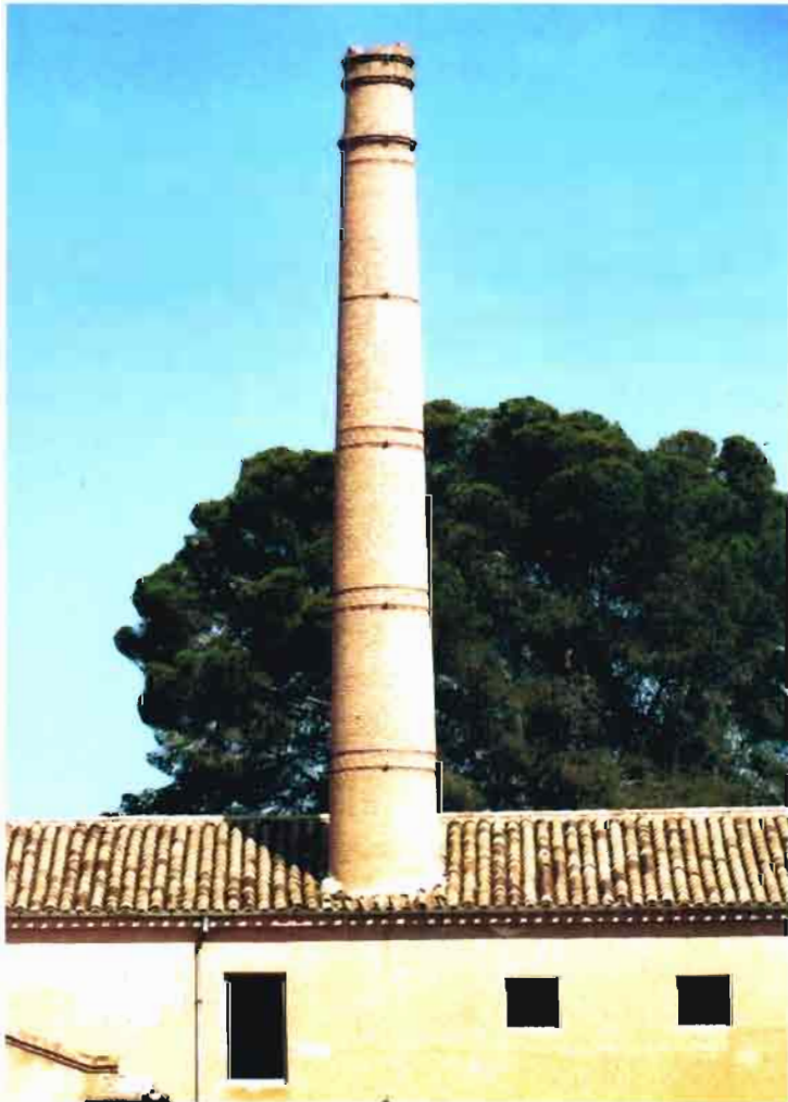
Fot. 34.- Hellín. Chimenea industrial
