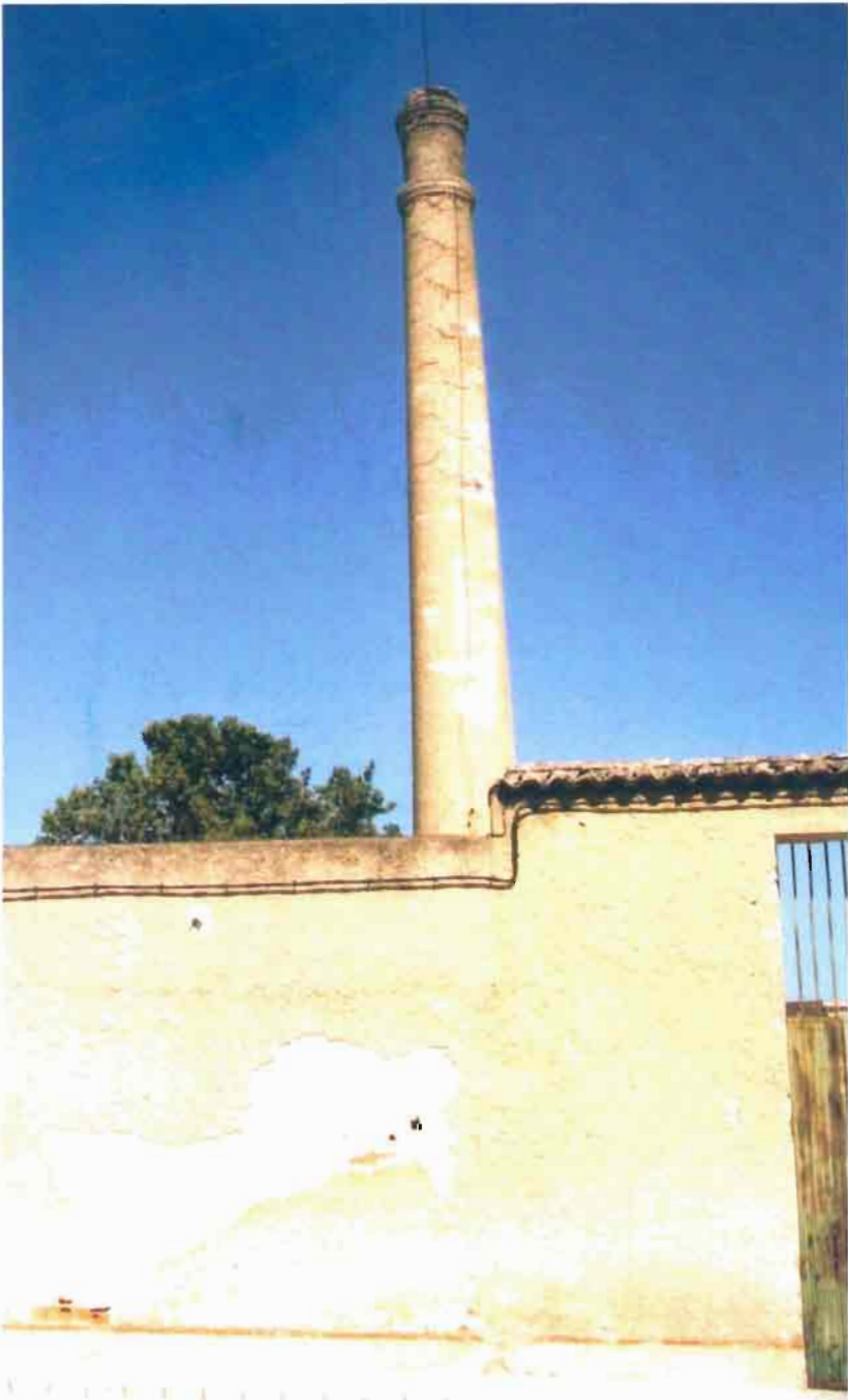
Fot. 32.- Hellín. Chimenea industrial
