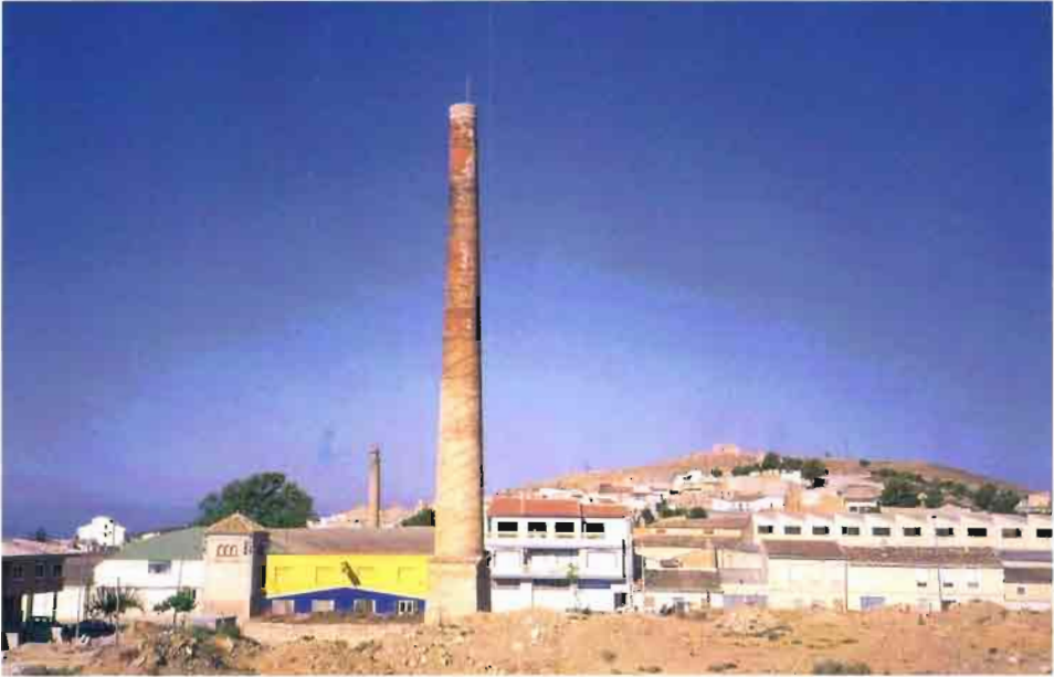
Fot. 61.- Hellín. Chimeneas industriales. Cerámica Vicente Garaulet Roca
