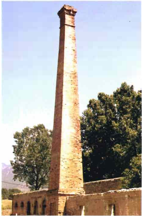
Fot. 45.- Riópar. Chimenea industrial.
