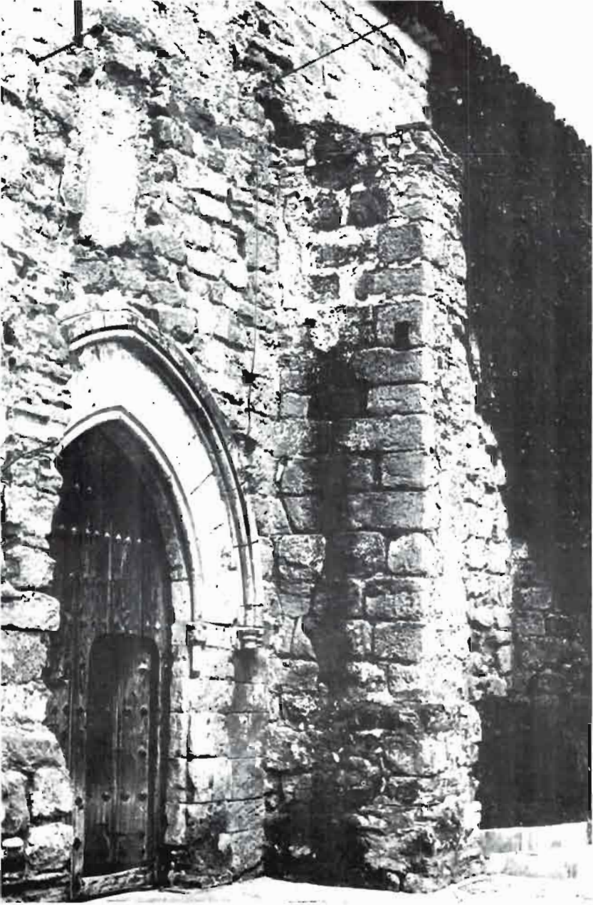
Puerta de ingreso.
