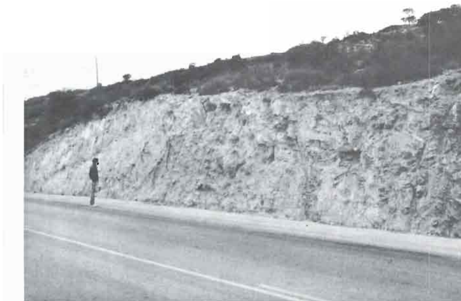
Foto n.º 8: Niveles competentes del Lías inferior-medio fuertemente levantados por los niveles arcillo-margosos del mismo término.
