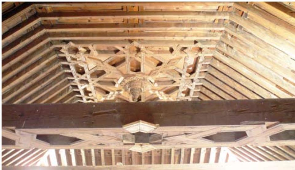
*Artesonado de la Ermita de Ntra. Sra. De los Remedios de Ayna típicamente mudéjar, con armadura de par y nudillo, ataujerada y cuadrangular, realizada en madera de pino con dos pares de tirantes centrales que apoyan en modillones y cuatro tirantes de ángulo que descansan en canes. La decoración alterna lazos, estrellas y rombos con un pinjante central.*
