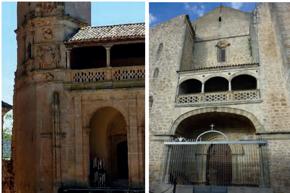
Torres y corredores de Alcaraz y de Villacarrillo.
