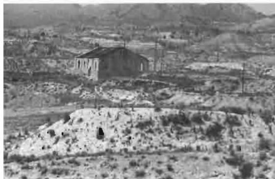
Vista general. En primer plano los escoriales; al fondo, restos de antiguas instalaciones.
