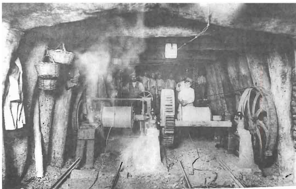
AZUFRERA DEL COTO DE HELLIN: PLANO INCLINADO EN LA GALERÍA DE TRANSPORTE
