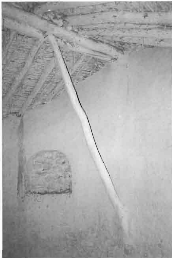
Detalle de la cubierta.
