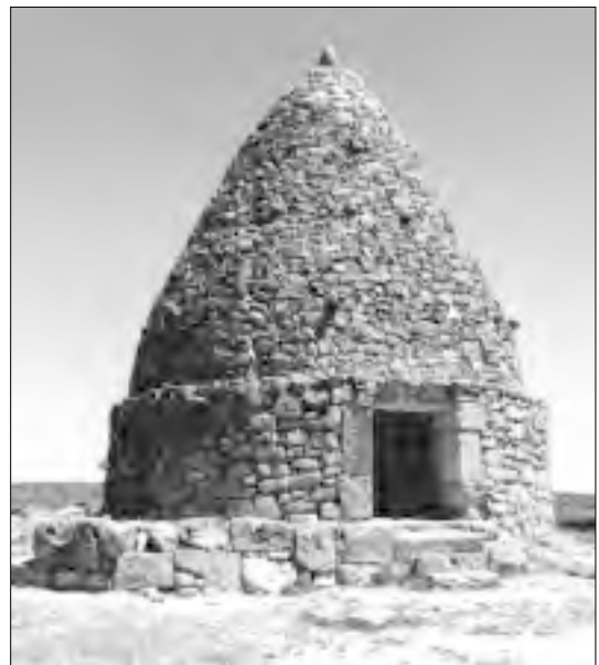
Foto 7.- Aljibe y pozo de nieve
