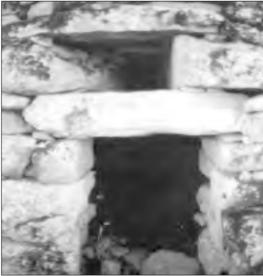
Fig. 1: Detalle de ventana por encima del dintel.
