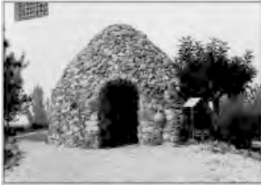
Foto 9.- Cuco del Centro de Interpretación Medioambiental de ADENE. Fue el primer cuco intervenido, siendo de nueva planta, sirviendo además de ensayo y entrenamiento a los artistas que posteriormente abordarían las demás actuaciones. El problema fundamental de este cuco fue la escasa superficie del suelo, por lo que fue necesario adosarlo a la pared, siendo pues imprescindible hacer cimientos y refuerzos de hormigón entre las piedras vistas del muro. La idea consiste en que los visitantes conozcan qué es un cuco, para qué sirvieron y cómo ha de abordarse sus visitas, antes de acercarse a cada uno de ellos.
