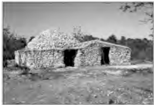
Foto 4.- Cuco de Miguel G. Bleda. Esta ha sido sin duda alguna la intervención estrella, la que mayor esfuerzo ha requerido, y la que ha obtenido unos resultados clave para la finalización del proyecto. De este complejo tan sólo quedaban en pie los muros y los dinteles de la puerta principal. Con la ayuda del propietario, quien indicó en todo momento cómo estaba esta construcción realizada, se pudo conseguir este resultado.
