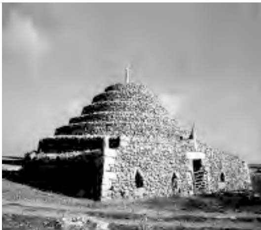
Foto 6.- Construcciones de utilidad ganadera
