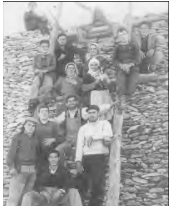
Construcción de un bombo en Villarrobledo, 1958.
