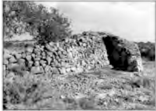
Foto 3.- Cuco de Teresa Camarasa. Es uno de los más interesantes debido a su fisonomía y planta. Aunque no es el único adosado a un muro de piedra o calzada, éste realmente integra esta calzada dentro del cuco. Su intervención consistió en reconstruir el muro que sobresale, muy castigado. Está situado en Las Turmas.
