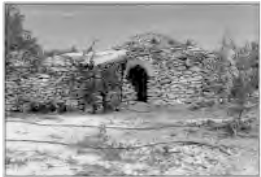
Foto 8.- Cuco de Teresa Francés. Está situado frente al cuco anterior, en la partida del Pelao. Es de destacar su anexo para bestias de carga, separada del cuerpo central del cuco. En su interior encontramos chimenea, banco rodado para el asiento de las personas, y un armario. En su exterior hay una escala para acceder al tejado.
