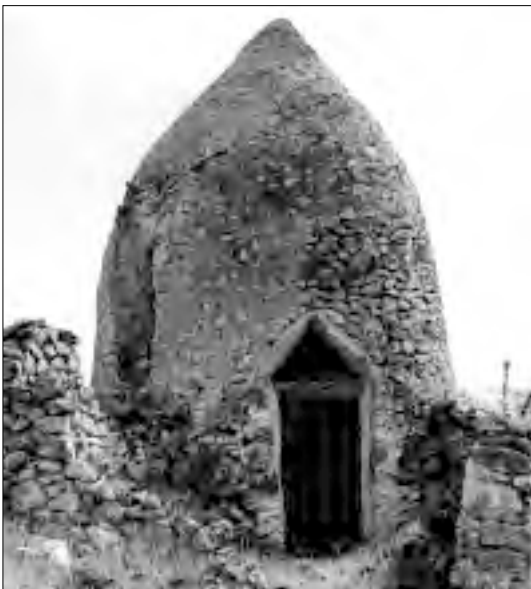
Foto 1.- Construcciones de planta circular y cierre de cúpula.
