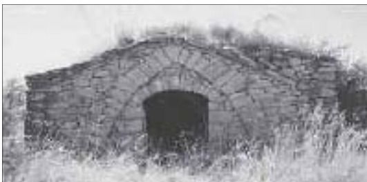
Cabaña cubierta con bóveda apuntada
