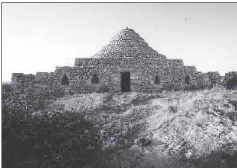
10. “Sa barraca” de la explotación de Ses Arenetes (Ciutadella de Menorca), que presenta una superposición de diez cuerpos, los tres primeros presentan la planta en forma de herradura. Se trata de uno de los más bellos ejemplos de barraques existentes en la isla.
