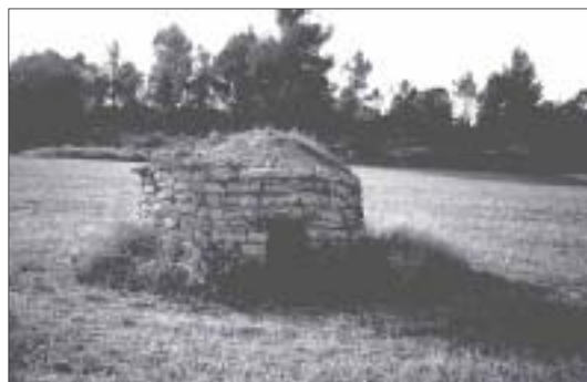
Foto 3. Construcción circular de reducidas dimensiones, situada en el centro del terreno de cultivo. Estas barracas representaban un refugio temperado ante los rigores de un clima caluroso en verano y propenso a los cambios bruscos.
