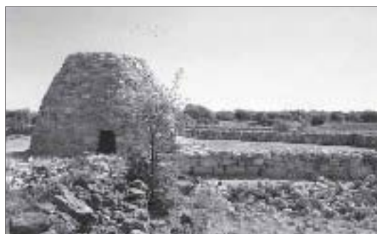
Foto 6.- Vista panorámica del chozo "La CabaÑosa" en proceso de rehabilitación.
