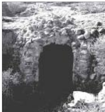
6.- Chozo Término municipal de Quel. Arriba: Vista frontal del chozo. Debajo: Detalle del arco de la cámara y del arranque de la bóveda
