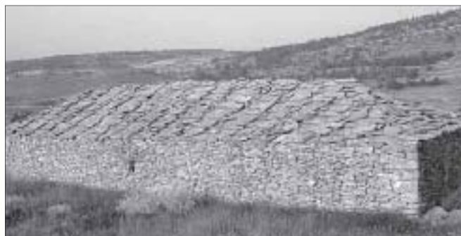
Mosqueruela. Caseta con dos falsas cúpulas por aproximación de hiladas y cubierta de lajas.
