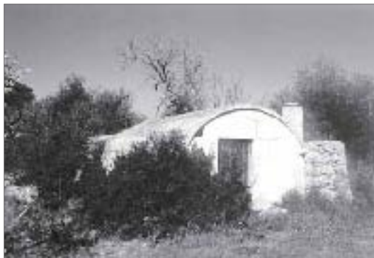
Barraca de establidor con cubierta de bóveda de medio cañón
