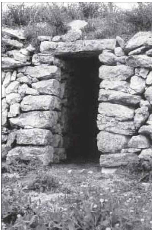
Portal de una “barraca de roter” de jambas plurilíticas y una losa como dintel.
