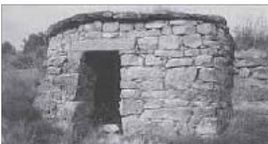
Cabaña cubierta por eliminación de ángulos
