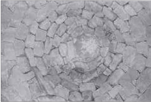
Cubierta de falsa cúpula
