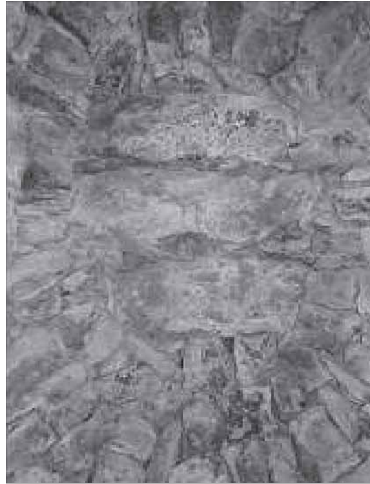
Cubierta de losas
