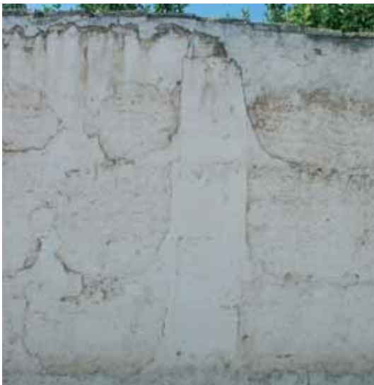
Tapia con brencas y juntas reforzadas
