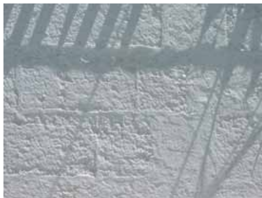
Tapia ordinaria con juntas reforzadas y encalado (Villarrobledo)
