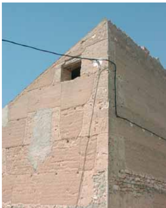
Tapiales reforzados con brencas en esquina. Casas de Juan Núñez (izquierda) y Fuensanta (derecha)
