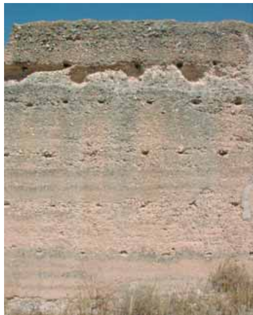
Detalle del paramento interior del tramo NO. Fortaleza de Jorquera
