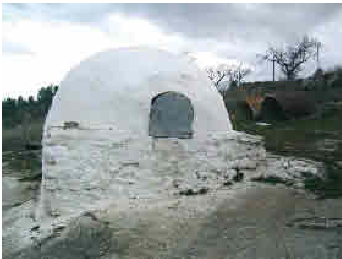
Horno en Juan Quiles (Yeste). En forma de cúpula y encalado y peana de mampostería sobresaliendo
