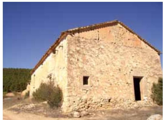
*En la parte baja del muro se está produciendo una importante pérdida de mortero de agarre entre mampuestos*
