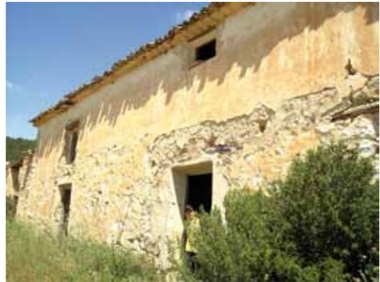
*Puede verse la línea que separa las dos tipologías constructivas en el muro, por el desconchamiento del mortero en la parte construida con piedra*
