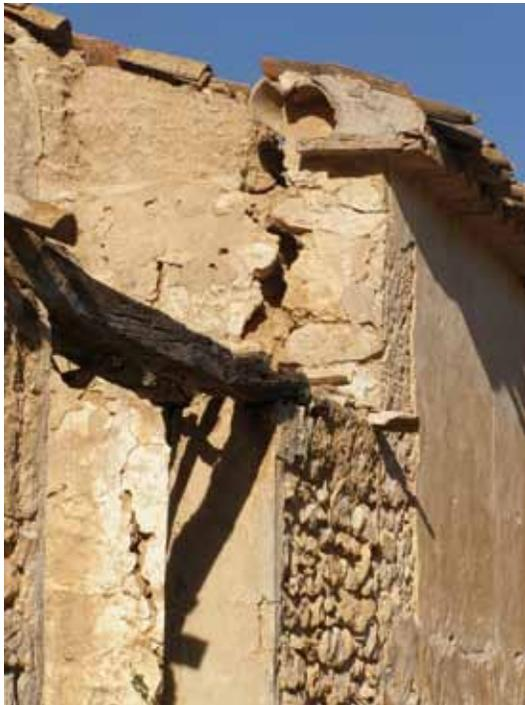
*Grieta vista desde el exterior. La anchura y profundidad de la grieta es mayor en la parte alta del muro.*
