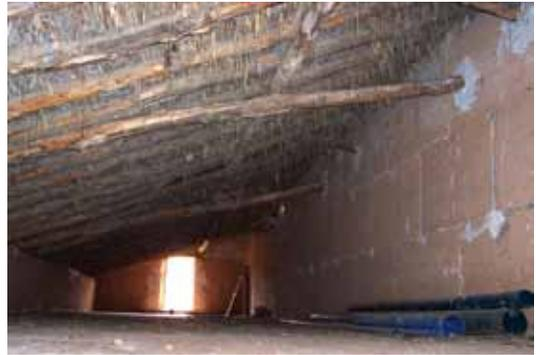
*Cubierta apoyada en muros de carga con parteluz. Casa Mondéjar. El Picazo*
