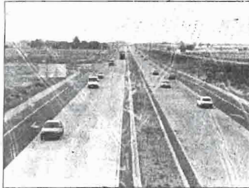
Carreteras peligrosas para el medio ambiente.
