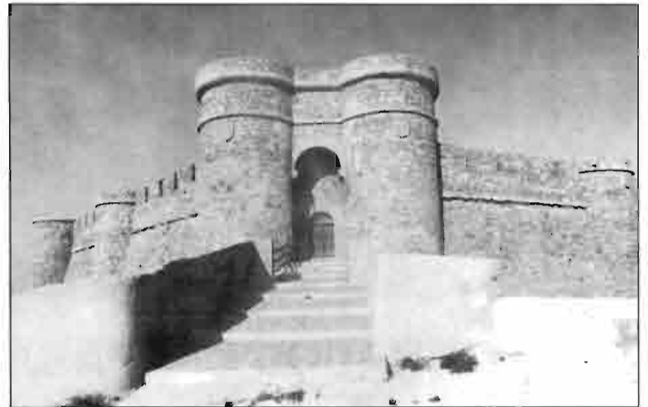
Aspecto que ofrece la entrada principal al castillo.
