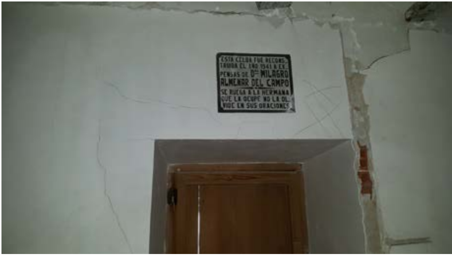
Figura 22: Celda del convento de las monjas agustinas.
