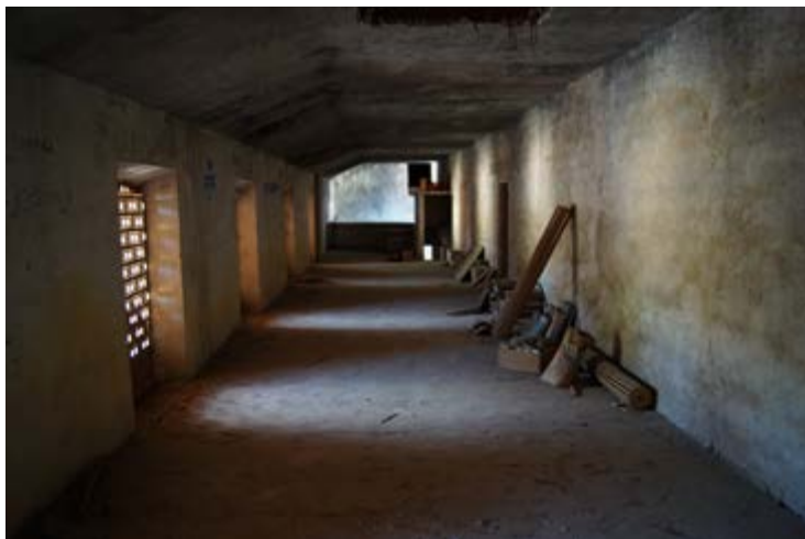
Figura 23 y 24: Estancia que corresponde con la antigua cárcel del convento.
