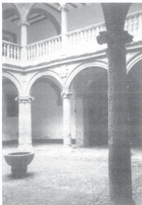
Patio de la Casa Grande. Los vértices del piso bajo se solucionan con la utilización de dos columnas adosadas a un pilar, mientras que en el piso alto aparece una sola columnas
