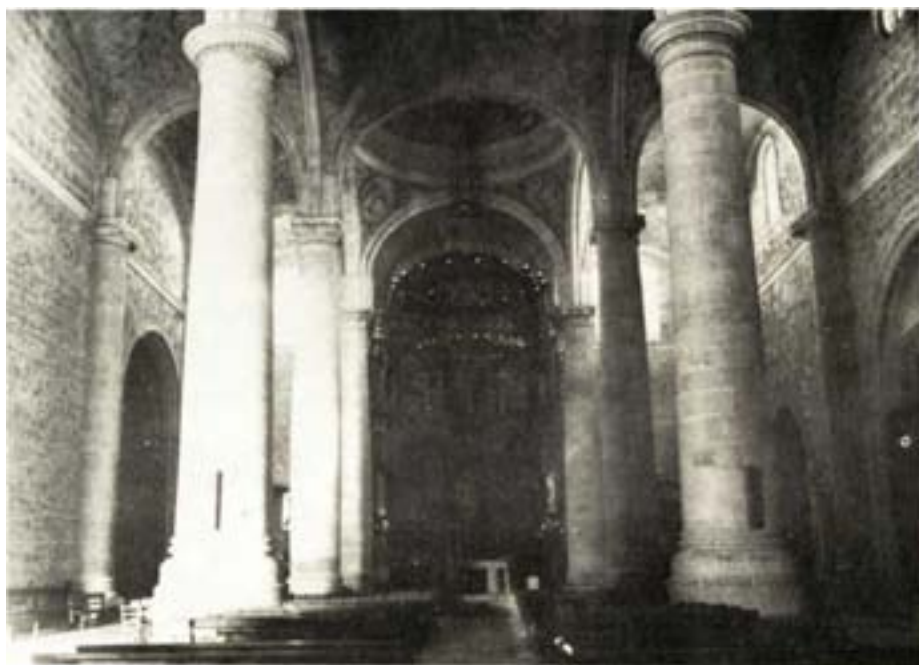
FOT. 2— LA RODA. Interior hacia lá cabecera.
