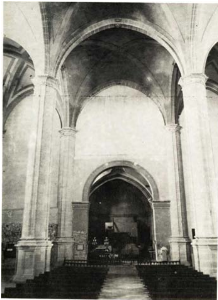
FOT. 5— VILLARROBLEDO. Interior hacia los pies. Tramos segundo y tercero. Al fondo, la obra cortada.
