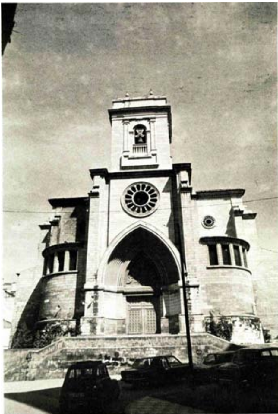
FOT.45—ALBACETE. San Juan Bautista. Fachada Principal. Estado actual.
