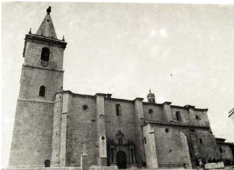
FOT. 1 — LA RODA. Iglesia de El Salvador. Aspecto exterior.
