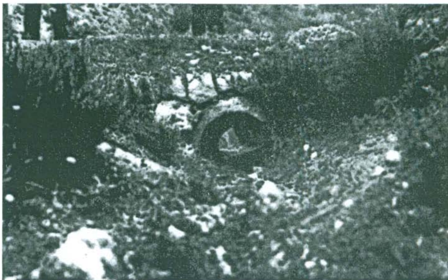
La alcantarilla donde murieron dos campesinos que se habían refugiado allí.
