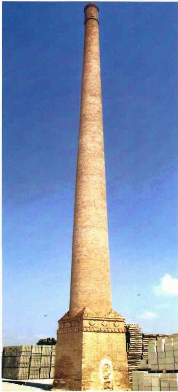
Fot. 40.- La Roda. Chimenea industrial
