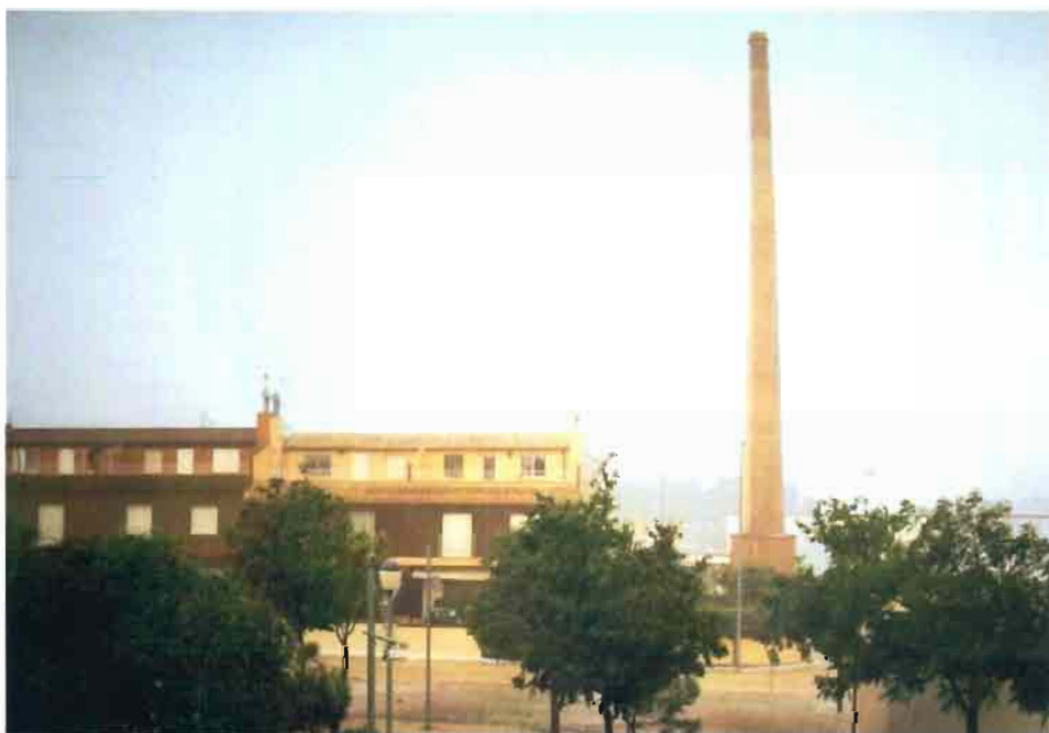
Fot. 54.- Almansa. Chimenea industrial. Cerámica Collado (C/ Hellín)
