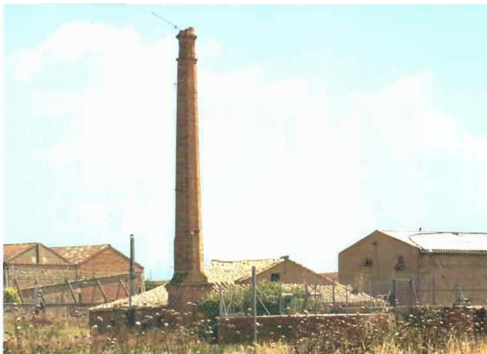
Fot. 67.- La Roda. Chimenea industrial. Fábrica de pastillas.
