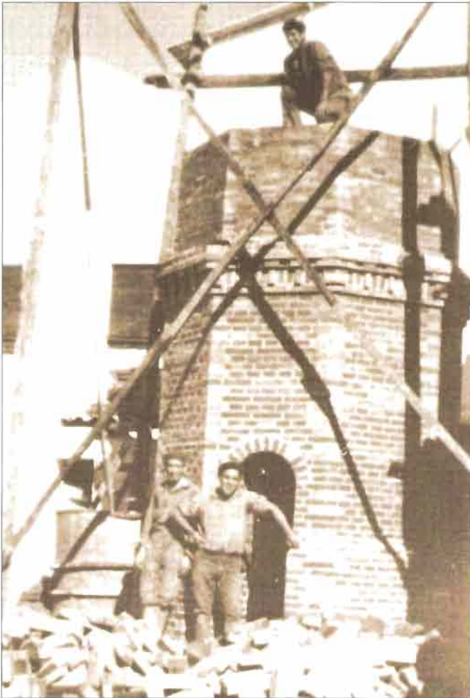
Fot. 3.- Basamento. Chimenea industrial
