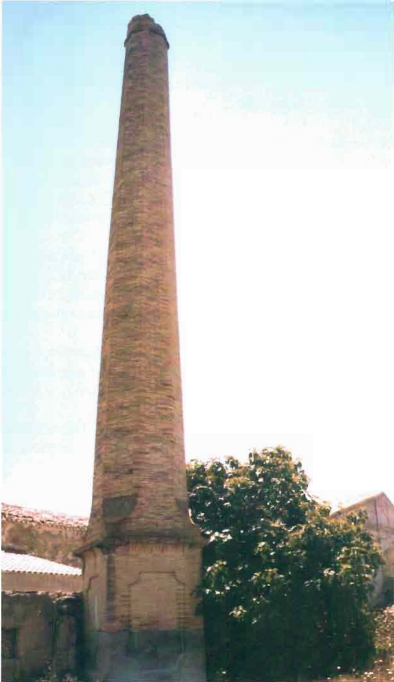
Fot. 37.- Jaso (Hellín). Chimenea industrial
