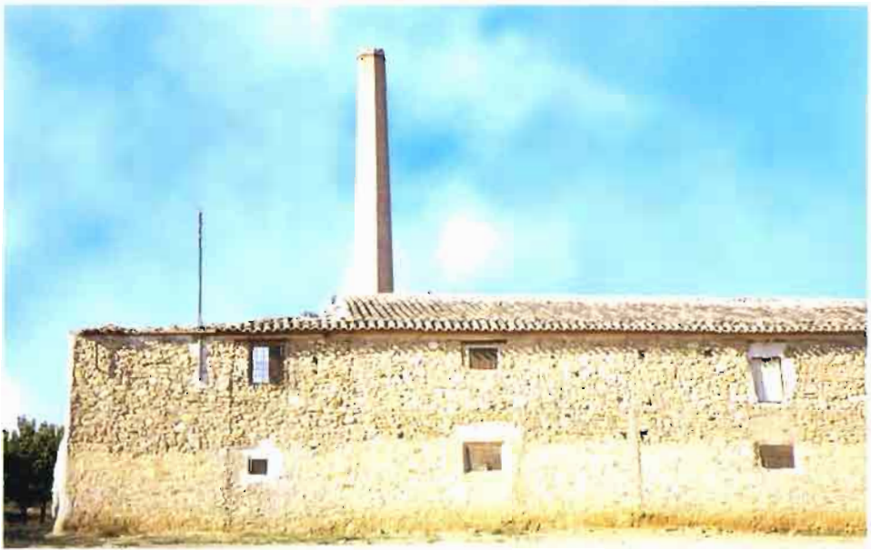
Fot. 70.- Tobarra. Chimenea industrial. ¿Fábrica de lanas?
