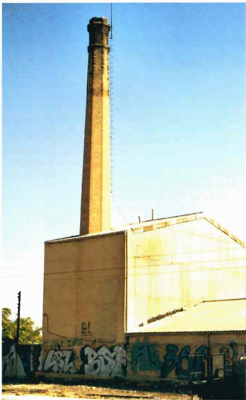
Fot. 22.- Almansa. Chimenea industrial
