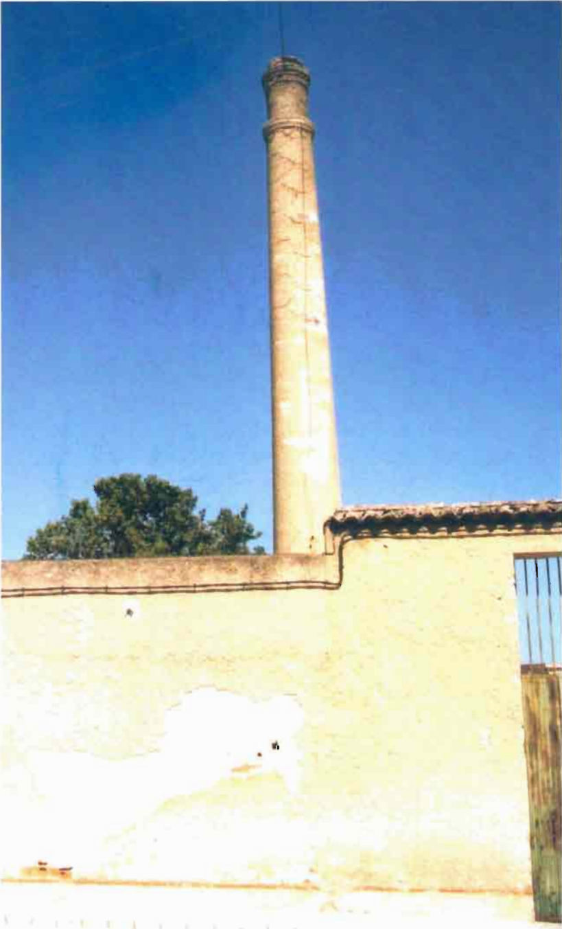
Fot. 32.- Hellín. Chimenea industrial
