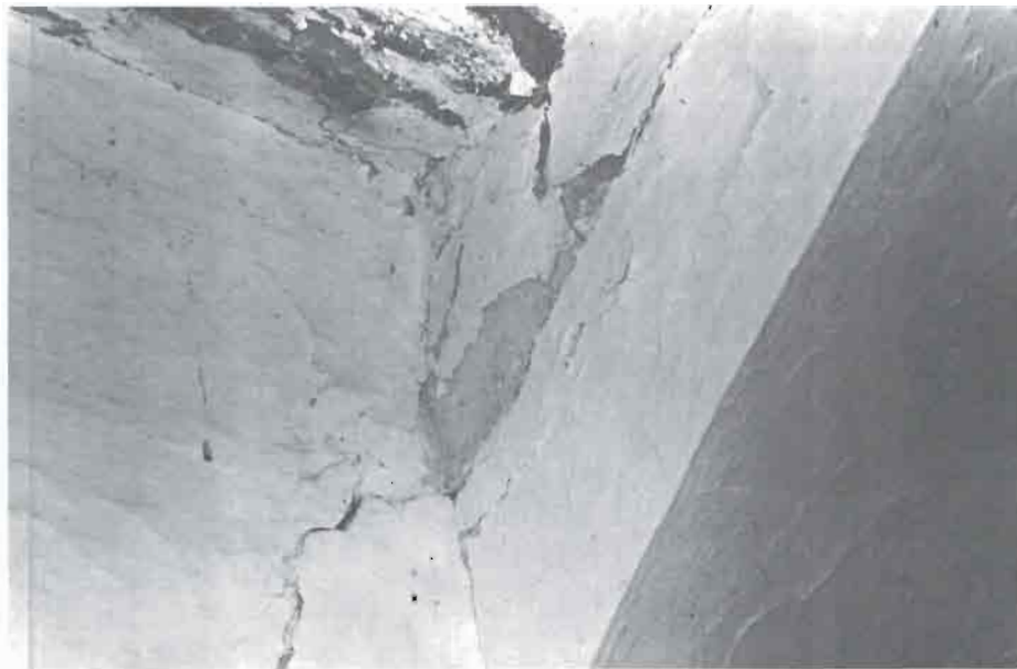
FOTO 19. Escalera en Santa Rosa.
