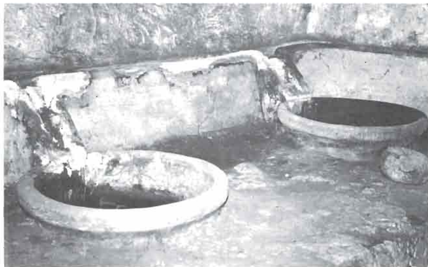
FOTO 13. Bodega de la Casa Vieja de los Crespos. Detalle de los conductos por donde circula el mosto y su llegada a las tinajas.
