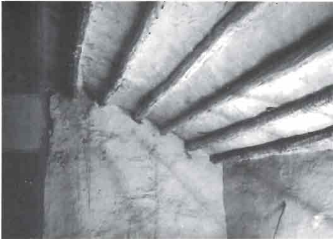
FOTO 33. Techo del granero de una casa de Los Aljibes.
