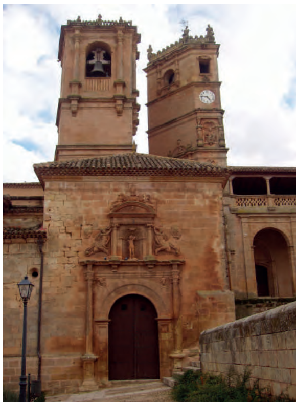
La capilla, costeada por el Ayuntamiento como obra concejil independiente y antepuesta a la torre y a la iglesia.
