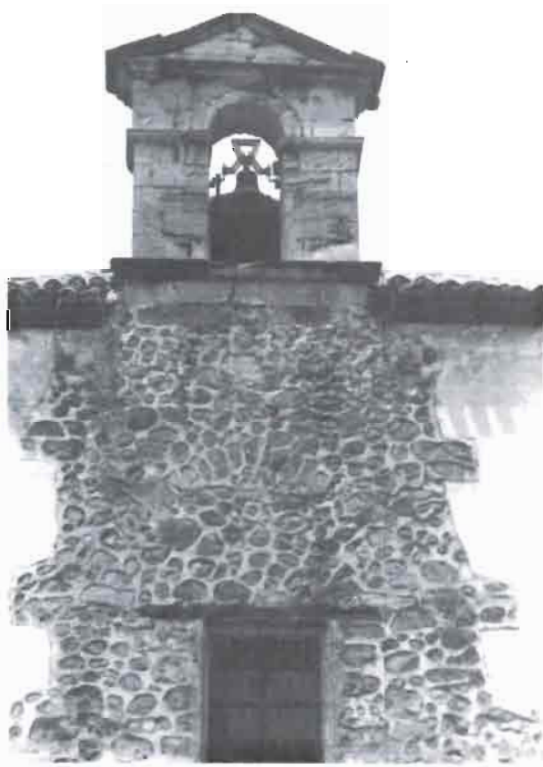
Fot. 22: Detalle de la fachada principal del convento donde se observa un arco cegado. (Fot. V. Carrión).
