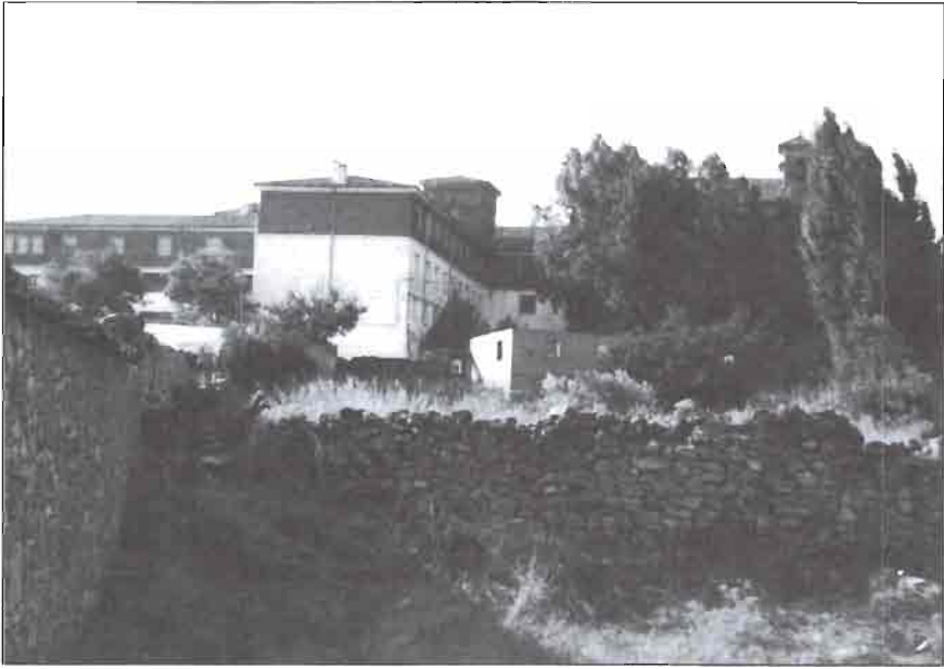
Foto n.º 8. Actual colonia del Santuario del Sahúco construida en el antiguo convento. Lado norte.
