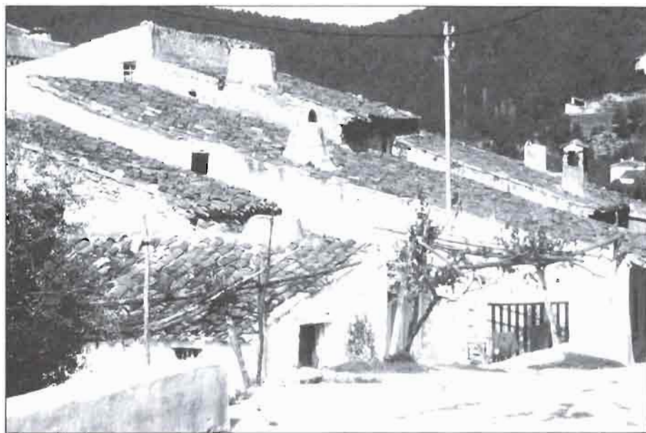
Foto n.º 19 Arquitectura doméstica en Góntar.
