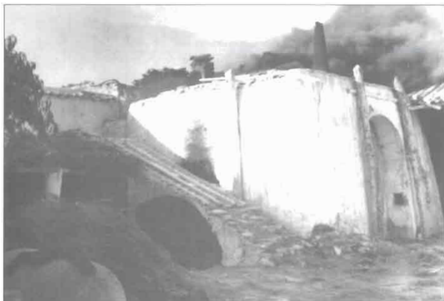
Horno en funcionamiento. Se puede ver bajo la rampa la subida de la «lumbre superior», la «olla» de carga.
