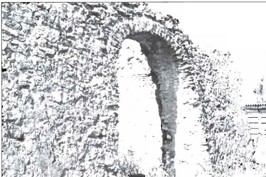
Restos de los muros del horno de A. Mañas. (Fot. García Gómez).
