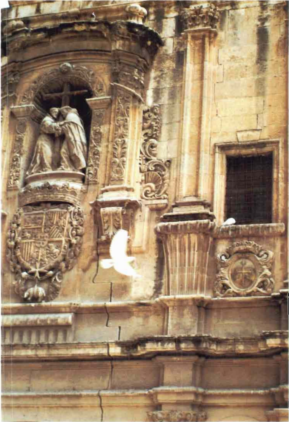
Iglesia de Santo Domingo (Murcia). Fachada oeste (detalle).
