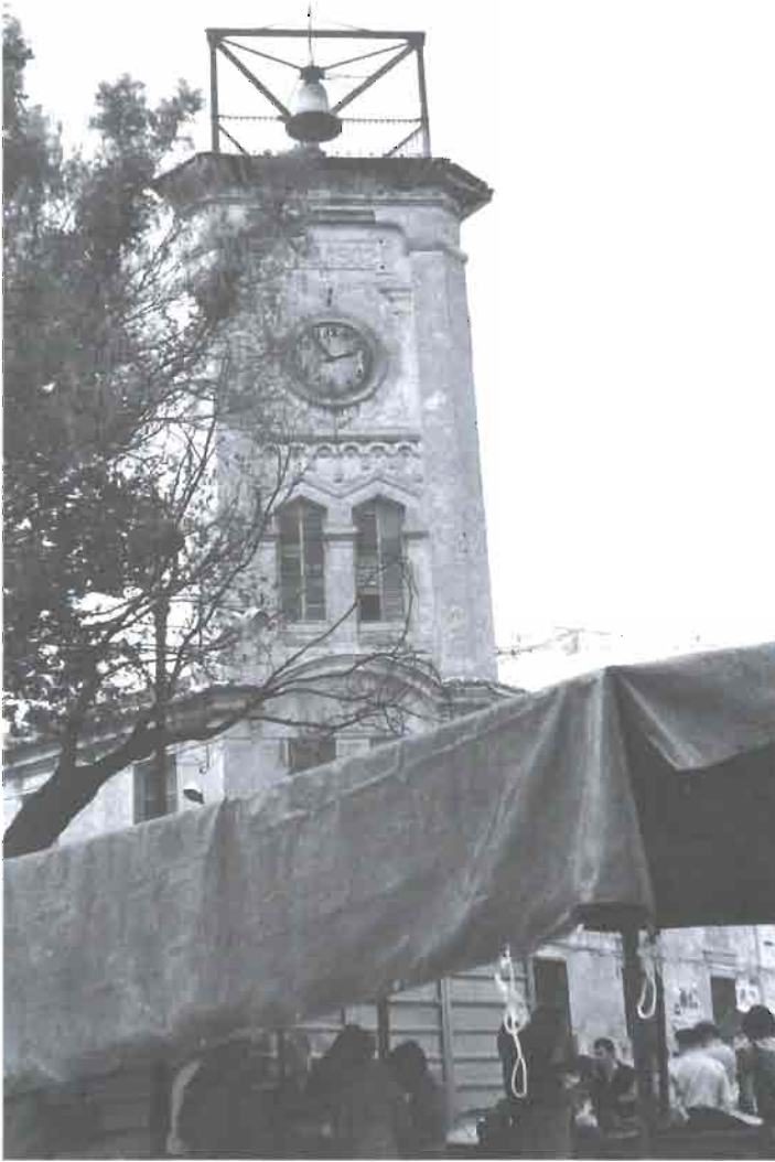
Fot. 14.- Reloj de la torre del antiguo Mercado de Abastos, instalado en 1902. (Archivo Fotográfico del Instituto de Estudios Albacetenses "Don Juan Manuel").
