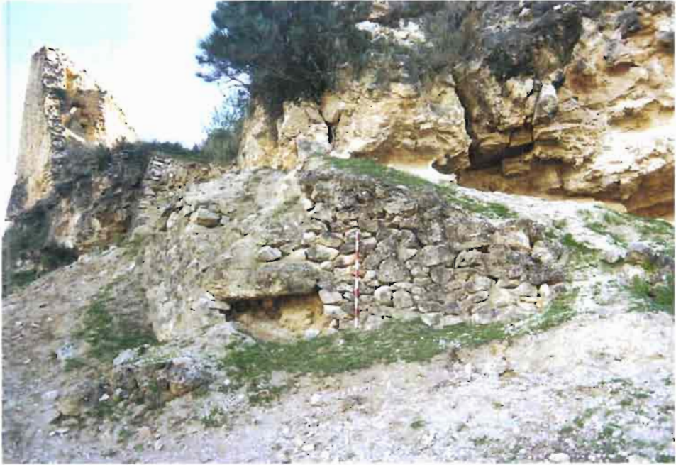
LÁMINA XXXII.- Vista general de la escalera de acceso al recinto interno.
