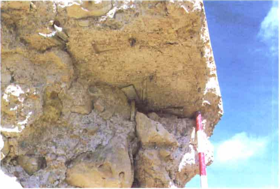
LÁMINA XXXV.- Aparejo de madera conservado en la cortina noroeste. En el centro se aprecia un ejemplo de “media aguja” con su clavo de madera.
