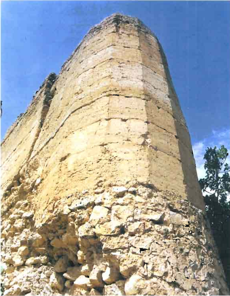
LÁMINA XX.- Exterior de la torre poligonal sur.
