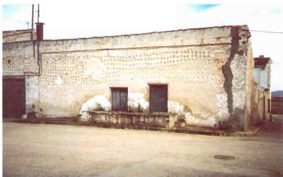
3.2 Bodega en Zulema (Alcalá del Júcar).
