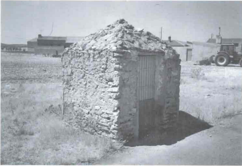
5.2 Pozo con cubierta a cuatro vertientes en Villavalliente.
