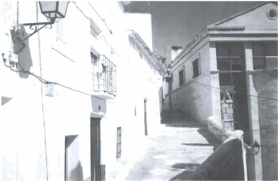
4.2 Vista de una calle en Jorquera.
