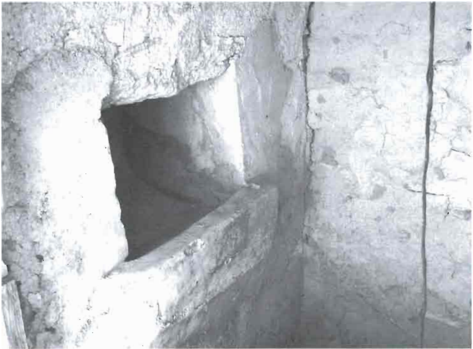
5.5 Boca para la descarga de agua a un pilón anexo.
