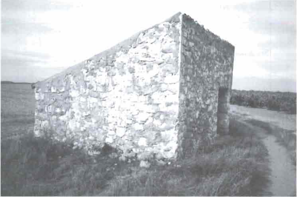
2.3 Casilla con cubierta a un agua (Término de Alcalá del Júcar).
