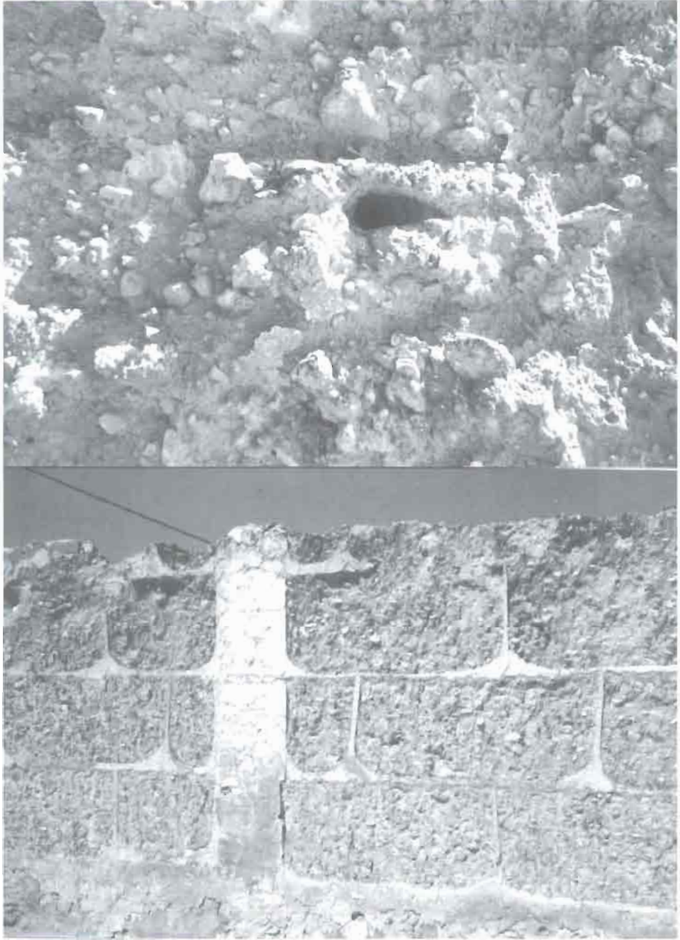
1.3 Agujal y muro de tapial de brencas con machón.
