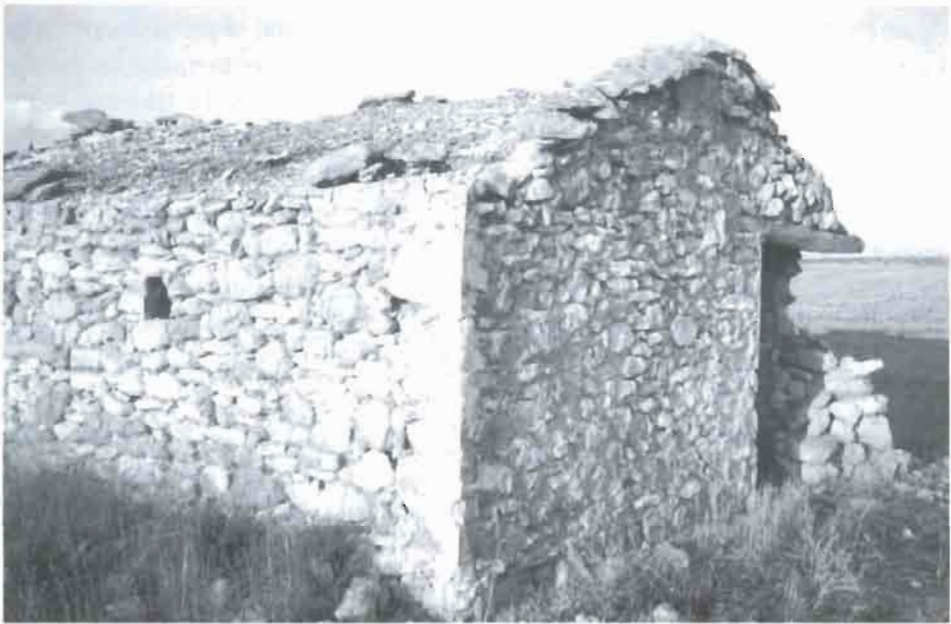
2.5 Casilla con cubierta de ceniza al SO de Alborea.
