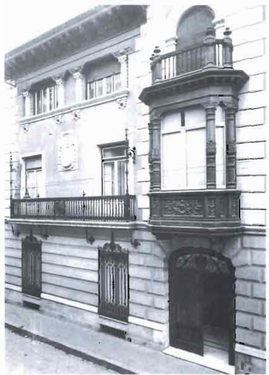
Fachada del edificio del Obispado en el momento de su inauguración. (Foto: Belda).
