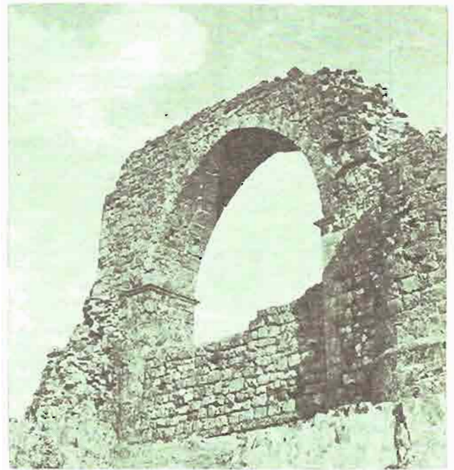
RESTOS DEL ACUEDUCTO ARABE DE ALCARAZ
