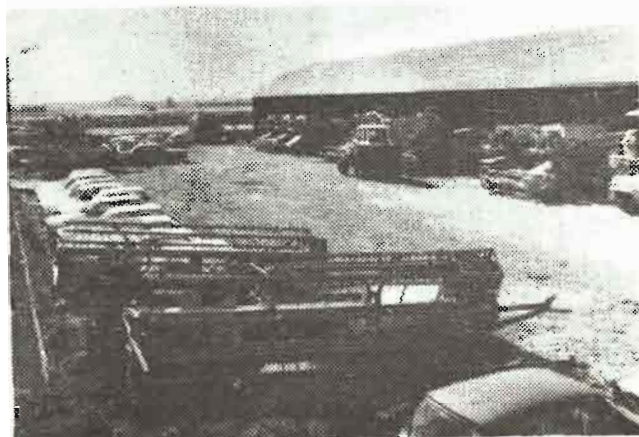
En la carretera de Mahora, los almacenes de AINCESA para maquinaria pesada y cosechadoras
