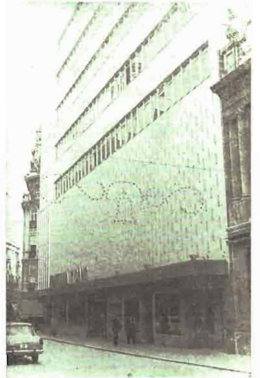
Otra calle conflictiva, la de Tesifonte Gallego
