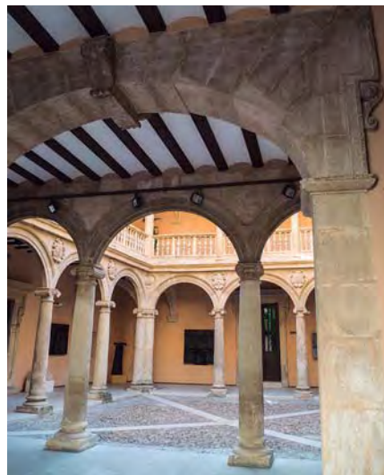
[6.2.] Arco de entrada al patio desde el zaguán de entrada. Al fondo, la puerta que daba acceso a la huerta y jardín privado del edificio.
