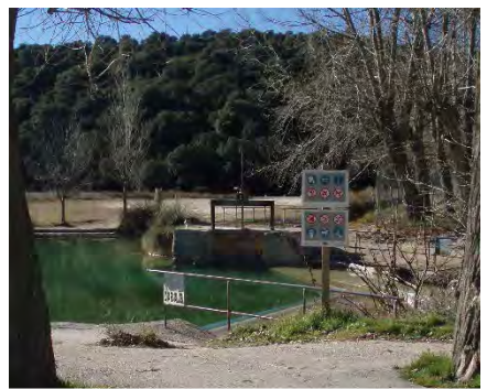
Azud que desvía los aportes de aguas superficiales hacia el baño de las mulas entre la laguna Tomilla y Tinaja
