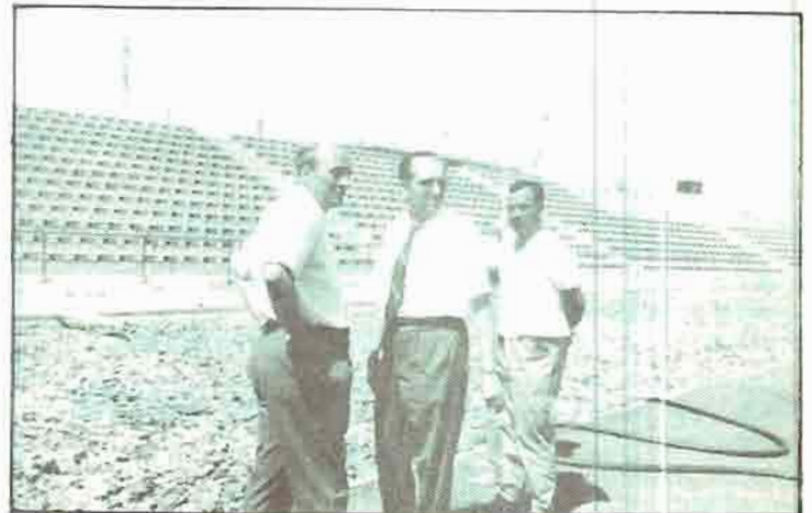
El arquitecto Carlos Belmonte, siendo alcalde de Albacete, dirigió las obras del estadio que lleva su nombre. Foto: Archivo CRÓNICA
