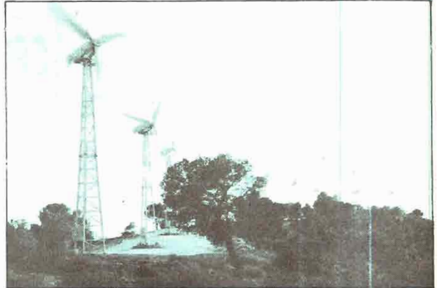
La batería de aerogeneradores, en la cresta de la Sierra de Enmedio, que constituyen el Parque Eólico de Ontalafia, cuarto de España.
