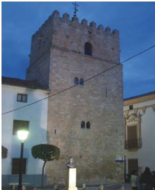
San Clemente. La torre
