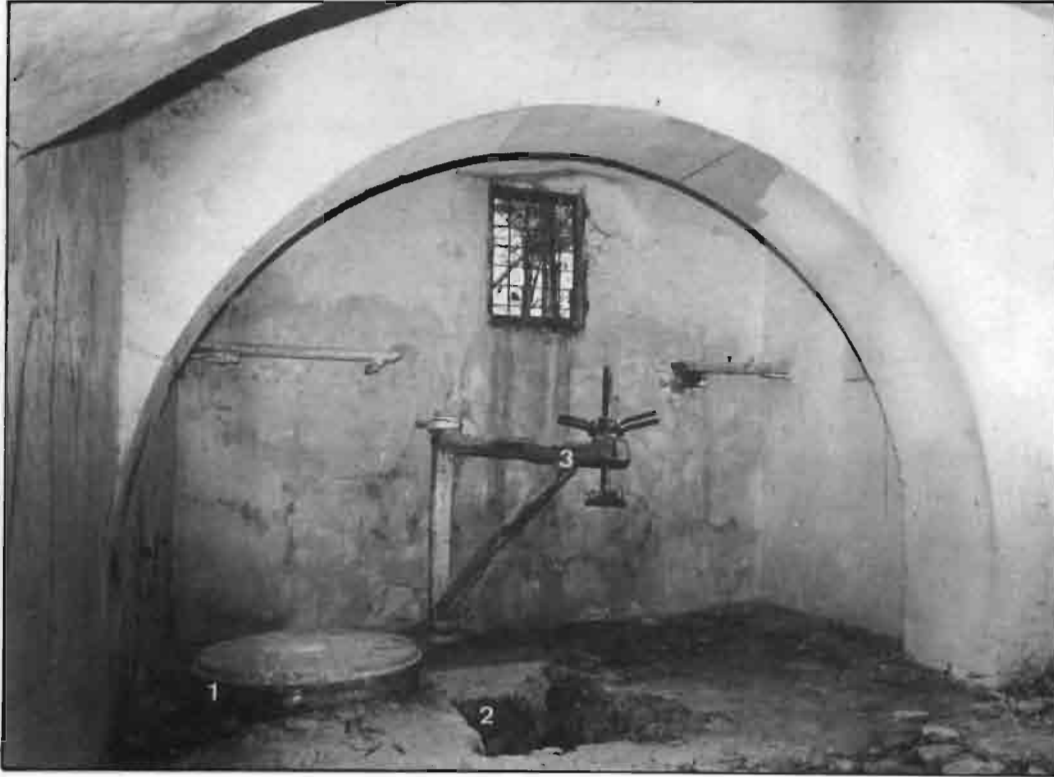
FOTO 3.—Interior de la sala de moler. Molino Alto.
