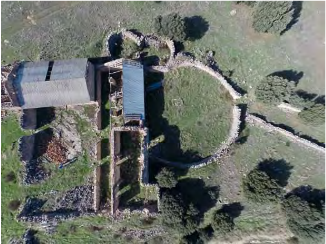
Fig. 83.- Vista cenital de la Ermita de El Salvador y los corrales anexos
