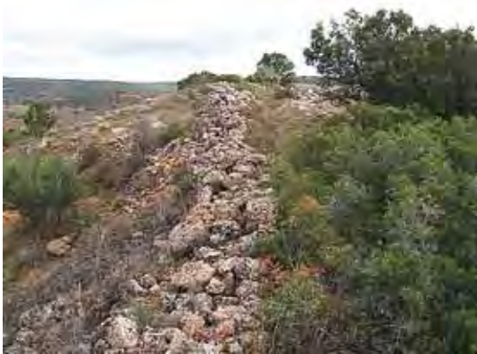
Fig. 96.- Muros en piedra seca del Cerro de Santa Bárbara (Alcaraz)
