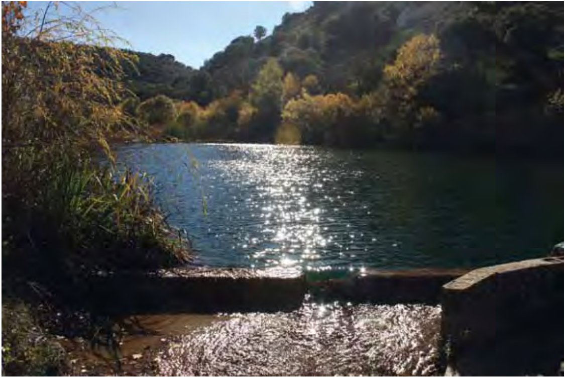
Fig. 125.- Presa de El Escorial, junto a la muela de El Santo (Alcaraz)
