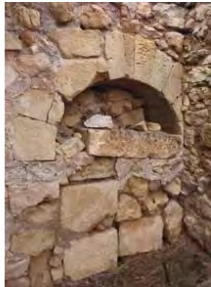
Fig. 84.- Interior del edificio anexo a la Ermita de El Salvador, con una puerta de sillería cegada
