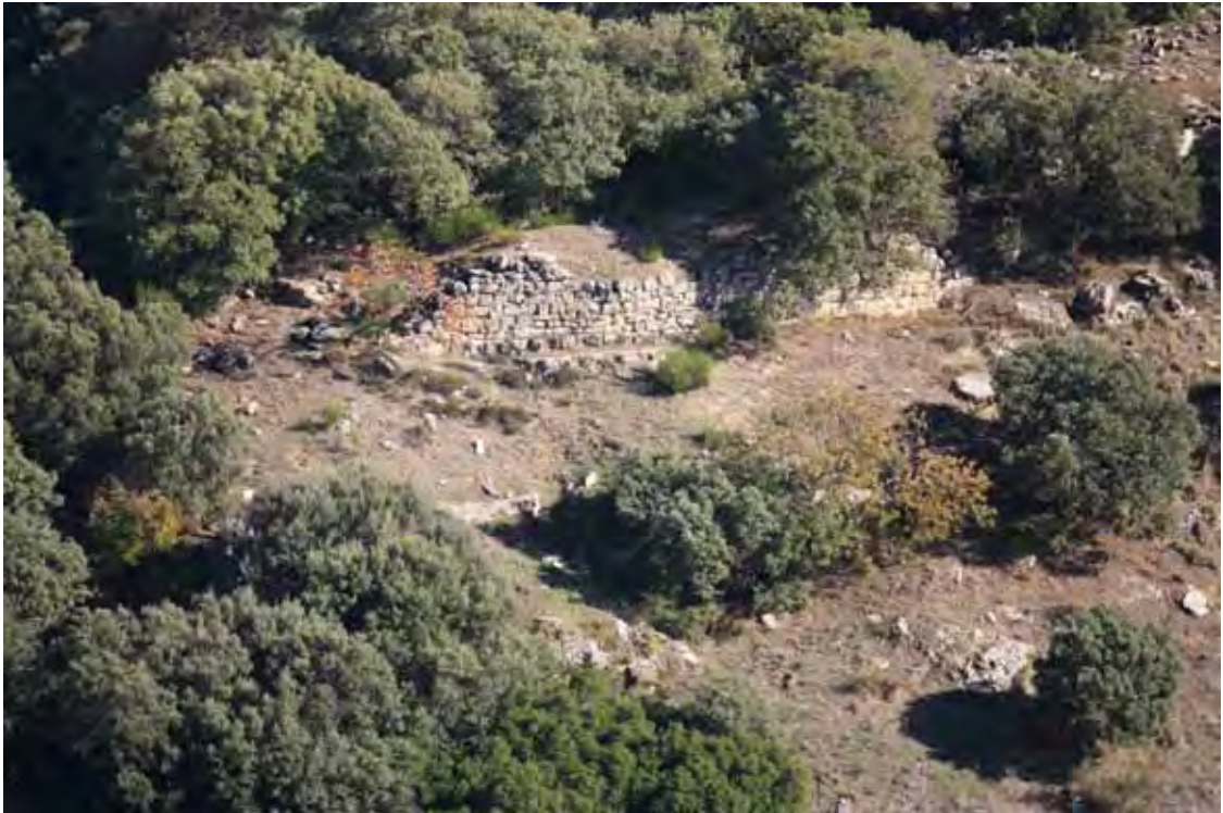
Fig. 41.- Vista general de la muralla en el tramo noroccidental del yacimiento
