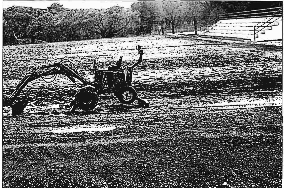
Aspecto de las obras del campo objeto de la cesión
