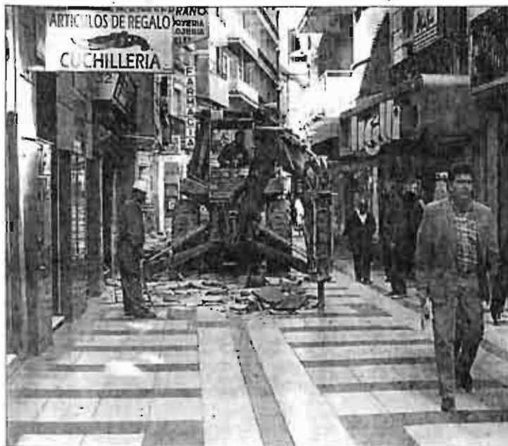
Los comerciantes de la calle Mayor se quejan del retraso de las obras. FOTO LA VERDAD
