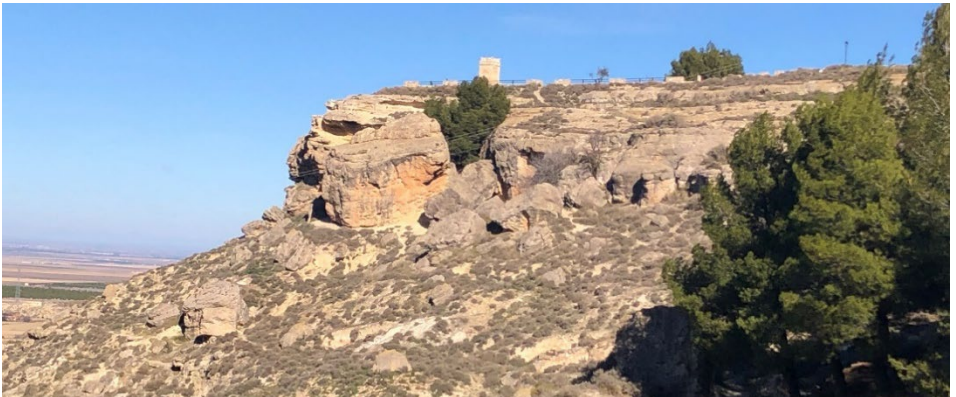
Figura 6. Vista oeste de Chinchilla de Montearagón elevada más de 200 metros sobre la llanura donde se aprecian numerosos bloques de calizas caídos sobre la ladera del monte.
