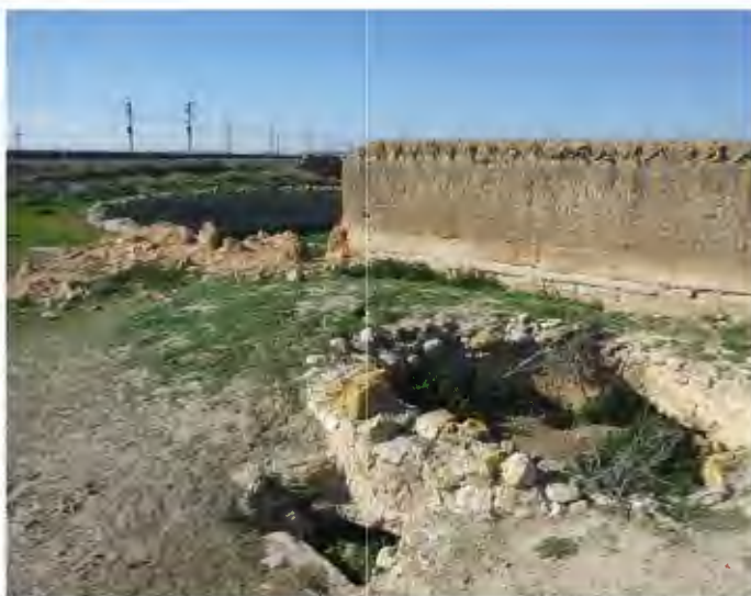
-Figura 18- Exterior de la balsa redonda, con su decantador y acequia subterránea.
