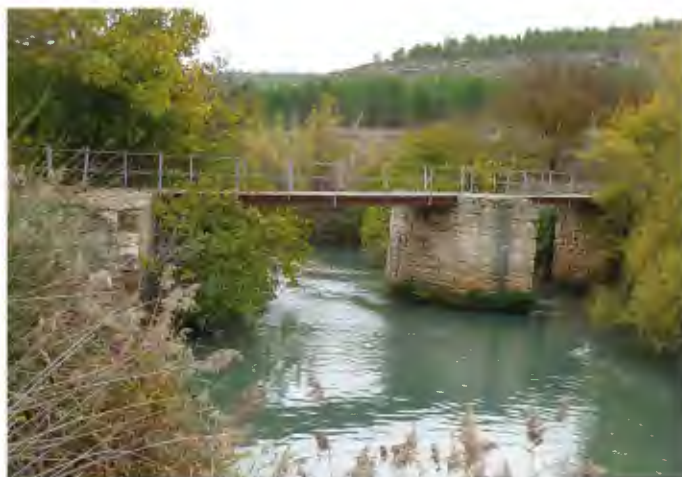
-Figura 12- Pasarela reciente sobre antiguos pilares. Puente Torres
