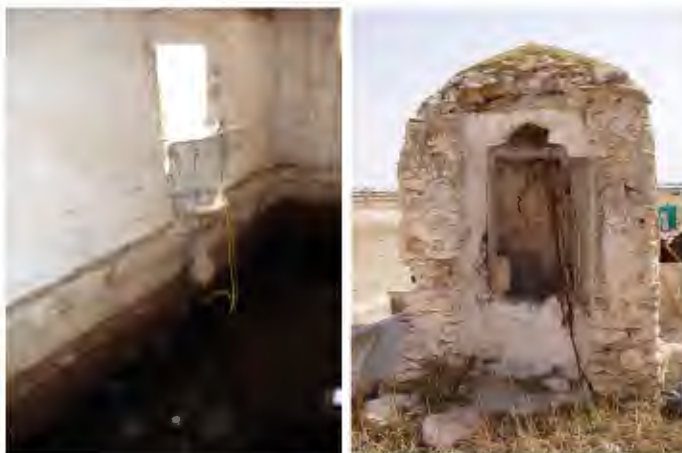
-Figuras 14 y 15- Interior y exterior del aljibe cubierto, en La Losilla.
