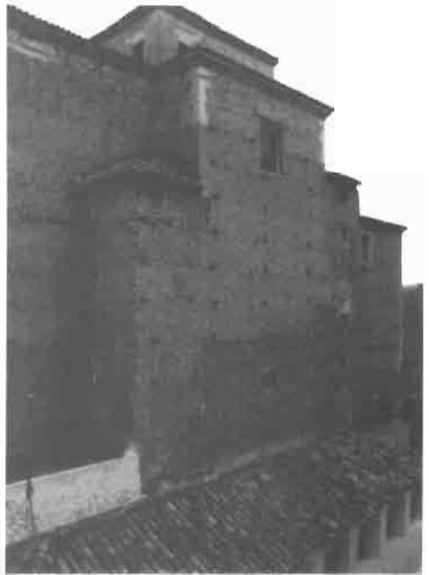
Fot. 53. FACHADA OCCIDENTAL O DEL RAMBLÓN. Convento
