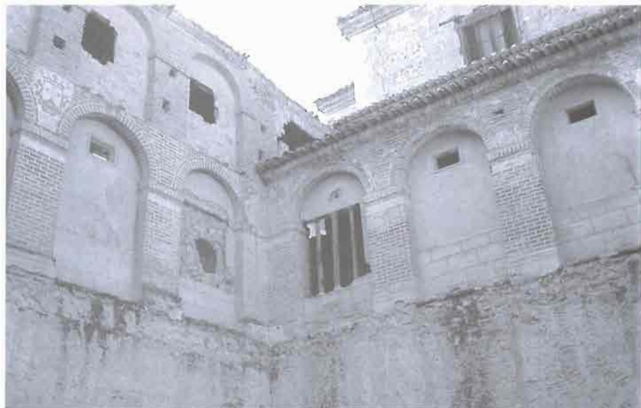
Fot. 48. FACHADAS AL PATIO DEL CLAUSTRO. Ángulo sureste. Convento.
