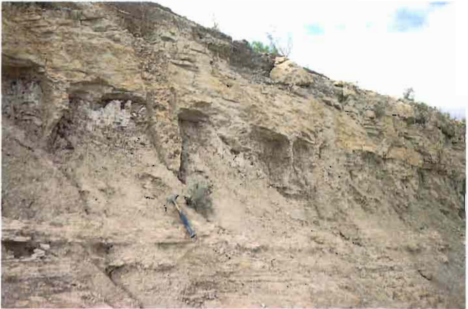
Fotografía CM9.1. Grietas rellenas en las capas de ciclos margas-calizas del tramo 3 de la sección del Cerro del Toril (CM9).
